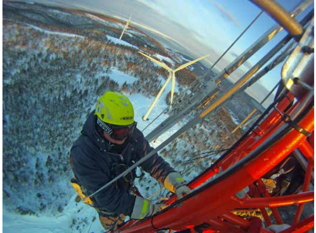
Figure 1. TechnoCentre éolien maintenance on 126-m met mast and two 2.05-MW Senvion MM92 CCV (Photo credit: TechnoCentre éolien)
