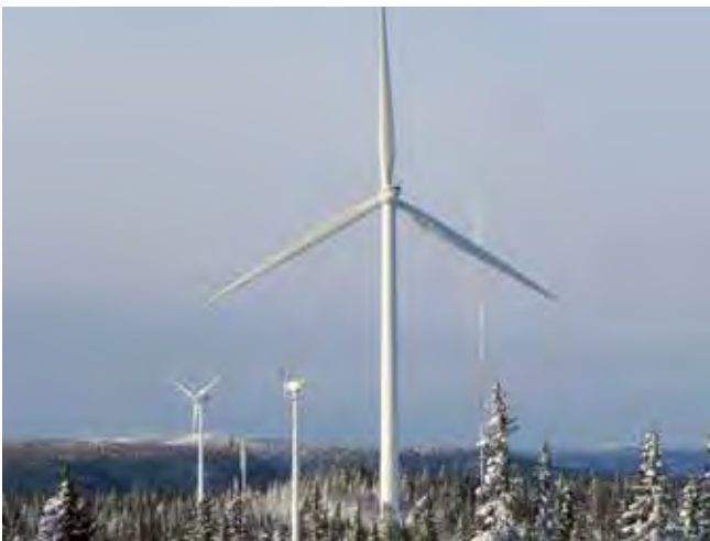
Figure 2. TechnoCentre éolien research wind farm 2.05-MW Senvion MM92 CCV; Eocycle Technologies EO-25/12 direct-drive, 25-kW wind turbine; 126-m met mast (Photo credit: TechnoCentre éolien)
