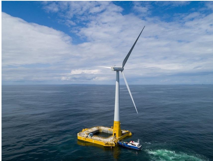
Figure 12: BW Ideol Floatgen Barge Floater. [15]
